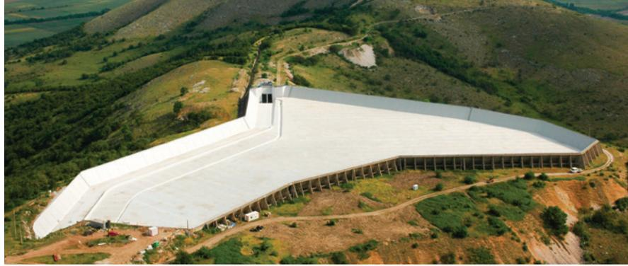
*Las geomembranas SIBELON® detienen fugas, evaporación y contaminación*
