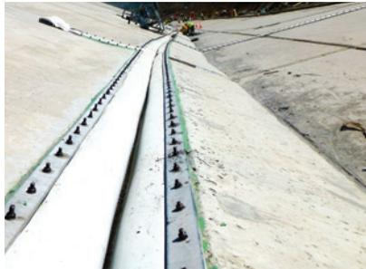
La estanqueidad en las juntas es crucial para un buen comportamiento de las presas. La estanqueidad se debe mantener a pesar de cualquier movimiento en la junta.
