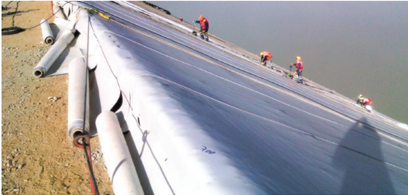
Las caras de geomembranas SIBELON® ventajosamente **sustituyen las de concreto o de concreto asfáltico**. Las geomembranas se pueden anclar a tiras de geomembranas embebidas en bordillos extrudidos, o a bandas de geomembranas empotradas en trincheras, o con anclajes profundos, o con lastre. Una geomembrana utilizada como núcleo central puede **sustituir núcleos de arcilla o concreto asfáltico**.
