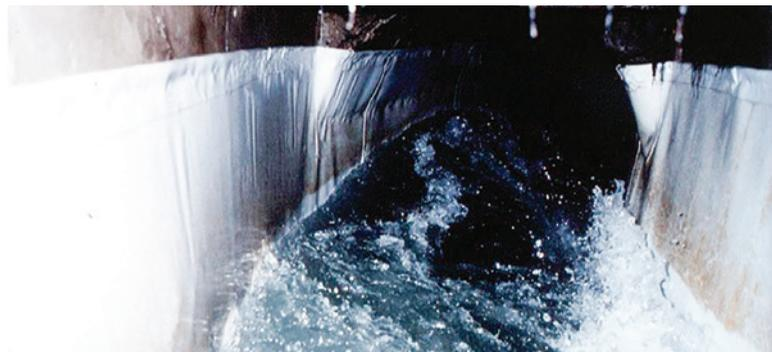
*Las geomembranas SIBELON® detienen las filtraciones, incrementan el flujo y minimizan el mantenimiento*
