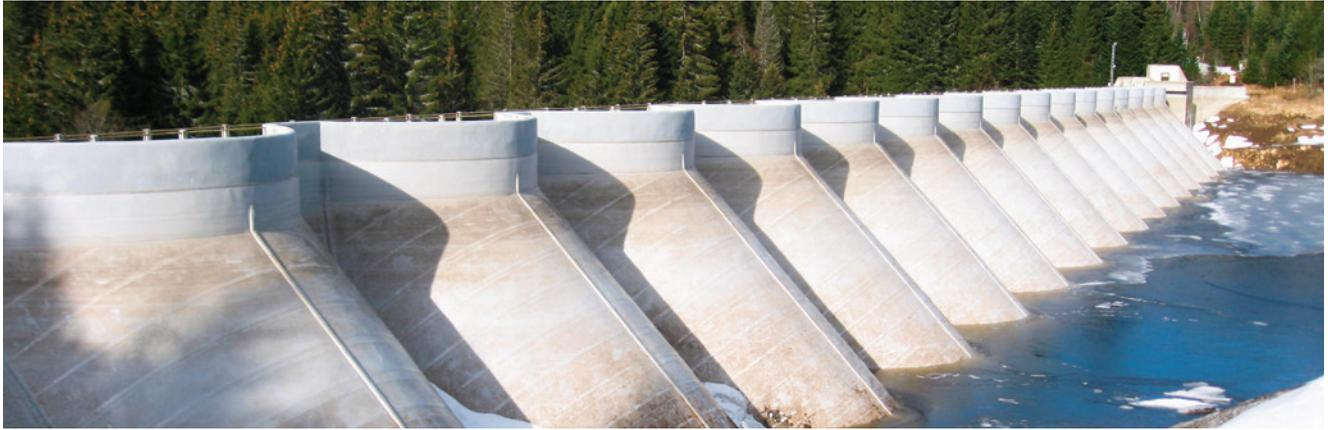
*Las geomembranas SIBELON® detienen la infiltración de agua y proveen protección contra el congelamiento y descongelamiento*
