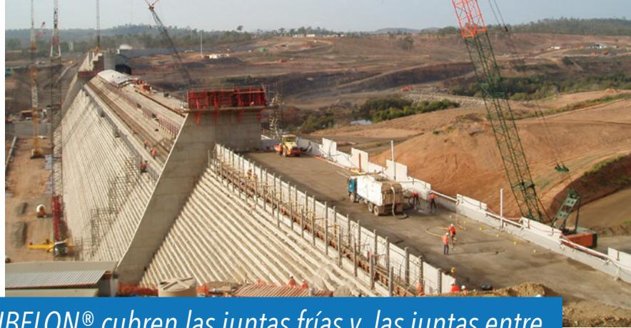
*Las geomembranas drenantes SIBELON® cubren las juntas frías y las juntas entre capas de CCR, reduciendo la subpresión*
